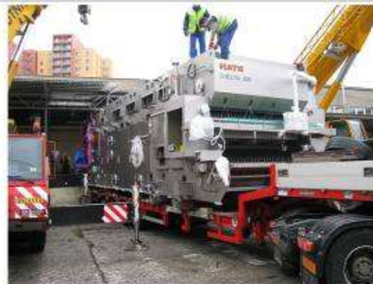
Бутыломоечная машина была выгружена на пивоваренном заводе в Остраве с помощью грузоподъемного крана.
