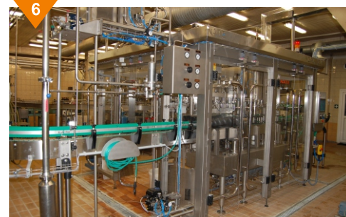
Dodávka nových částí linky: VERAL 25/5, ATHENA10/08.3, dopravníky lahví, elektrorozvadeč
