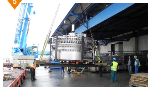
Demontáž, převoz a instalace 2 plnicích linek hot fill + CSD z Covasny do Bukurešti
