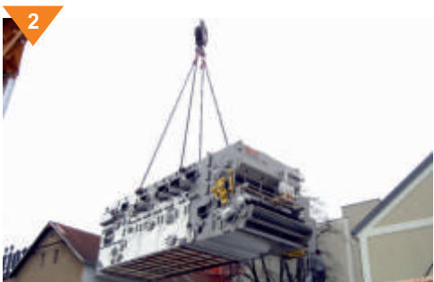
2 Demontáž a instalace nových částí linky
